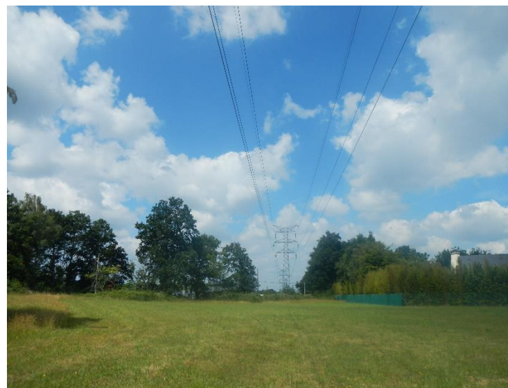
Figure 106 : La ligne électrique AURAY-THEIX au sud du site (Source : Egis, juin 2021)
