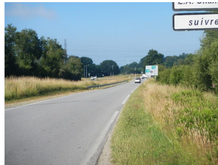
Figure 97 : Bords de route de la RD775 non-aménagés pour les piétons depuis l'arrêt « Tréalvé » (Source : Egis, juin 2021)
