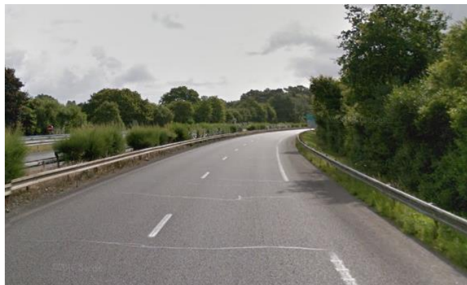
Figure 80 : Photographie - RN166 au nord du périmètre d'étude (Source : Egis, juillet 2017)
