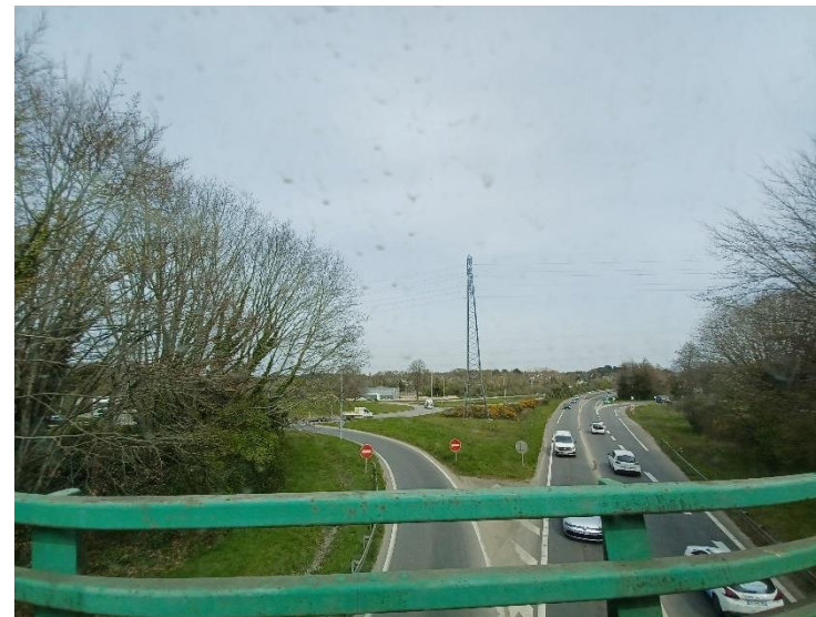
Figure 67 : Vue vers le site et le giratoire du Chapeau rouge depuis le passage supérieur de la route de Rennes au-dessus de la RN 166 (vue 13) Source EGIS, mars 2022
