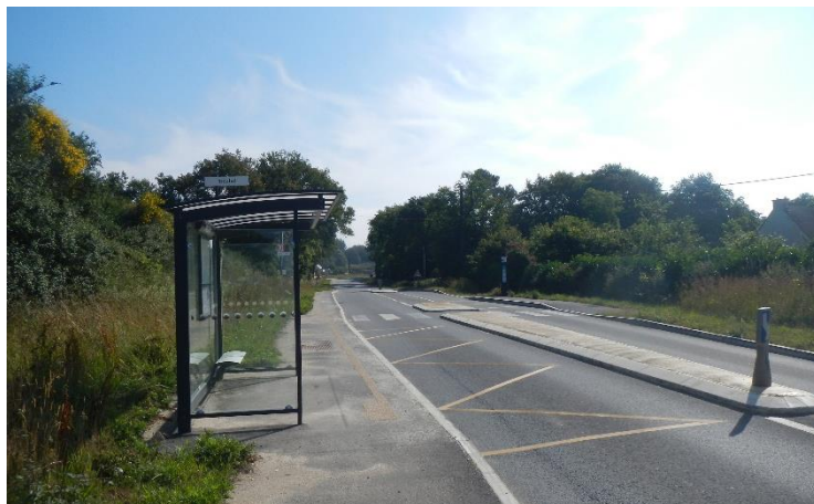
Figure 96 : Arrêt « Tréalvé » RD775 au nord (Source : Egis, juin 2021)
