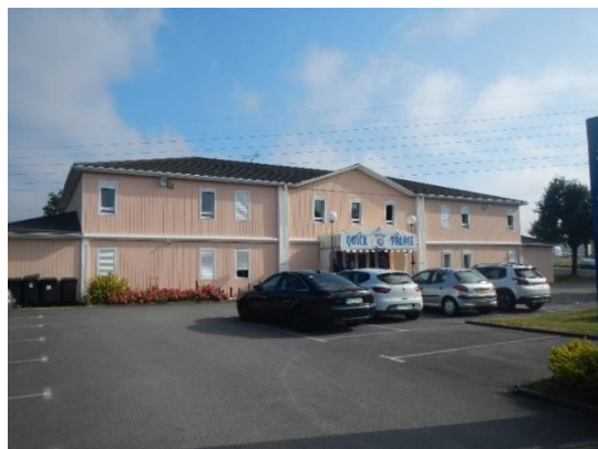
Figure 74 : Hôtels dans la zone du Chapeau Rouge - Source : Egis juin 2021
